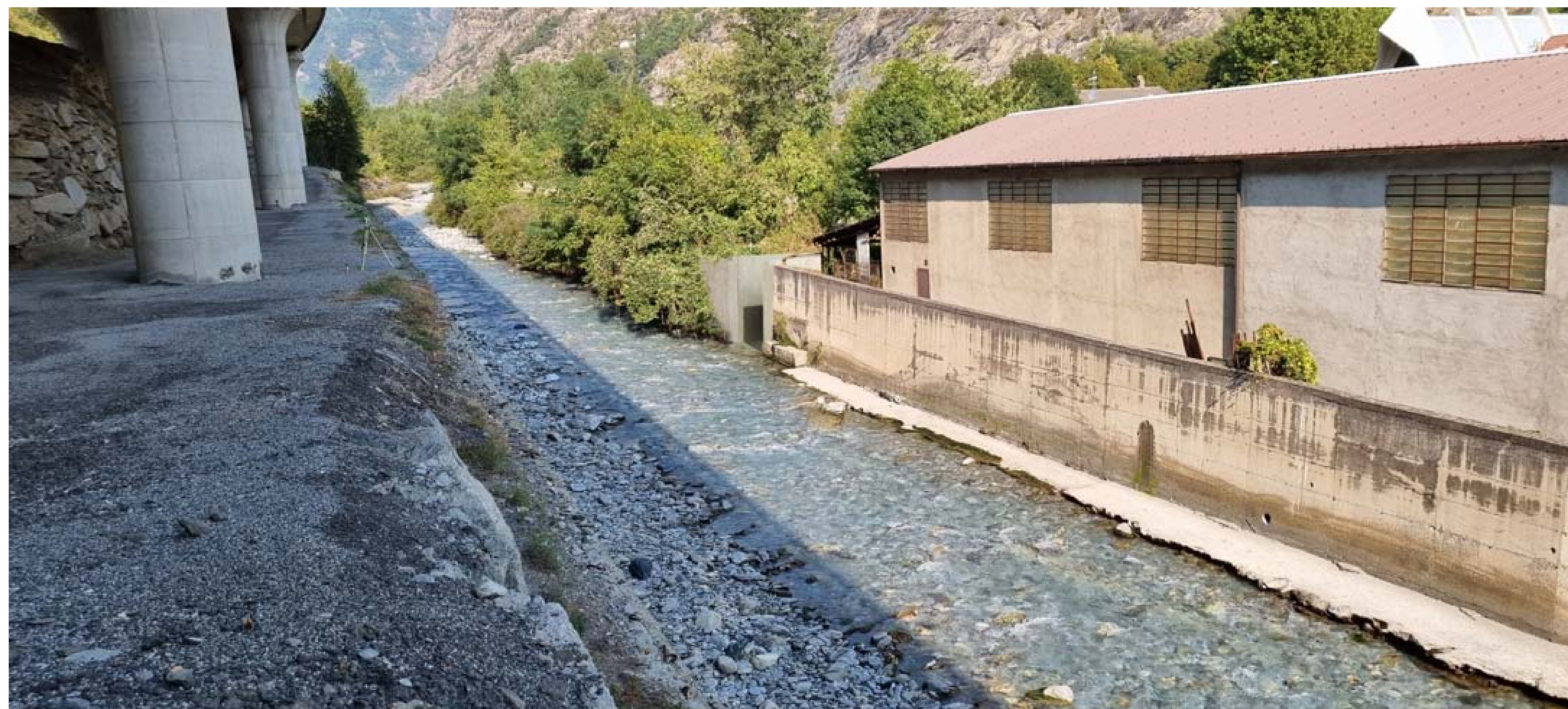
Foto 1 - Panoramica con vista da valle del Torrente Cenischio - Stato di progetto
